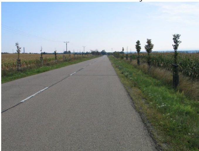
Foto 13: Pohled na na koridor K-D2 od jihu.
